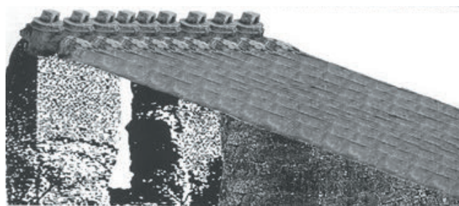
Рис. 1 Часть сифона (дюкера) акведука в Лионе из девяти труб с кранами
