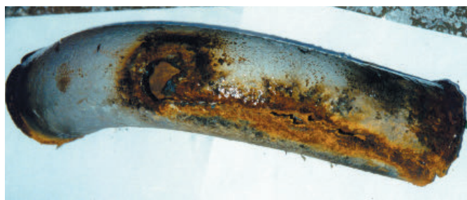
Рис. 2 Отказавший крутоизогнутый отвод газонефтяного трубопровода
