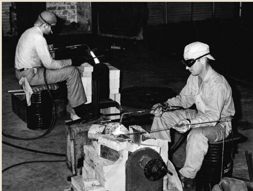
Начало 1950-х годов. Наплавка из кобальтсодержащего металла наносится на диски пробкового крана методом газовой (ацетилено-кислородной) сварки
