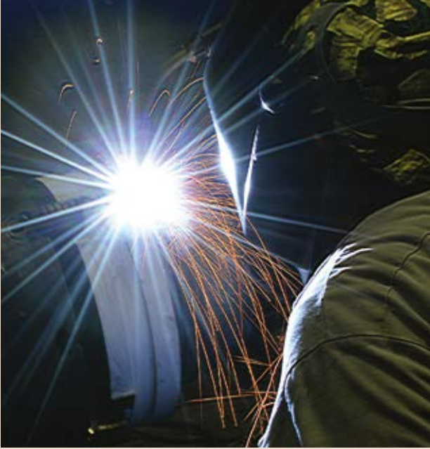
Газодуговая сварка металлическим плавящимся электродом применяется для нанесения наплавки Инконелем на диск запорного клапана
