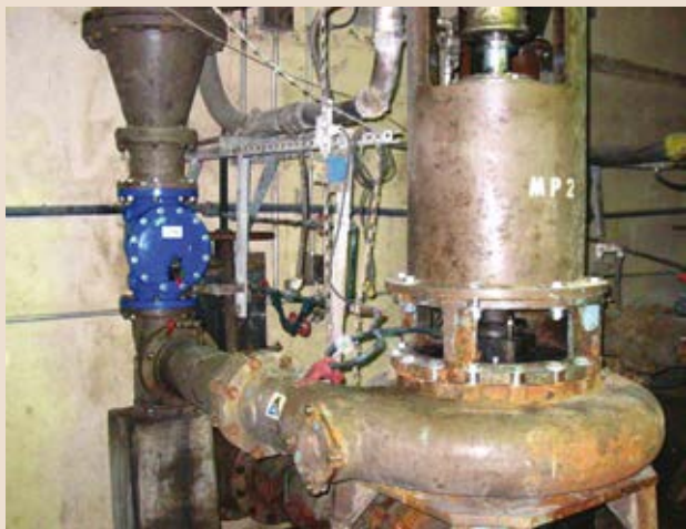
Центробежный насос и обратный клапан с мягким уплотнением в затворе и шарнирно закрепленным диском в сухом колодце канализационной насосной станции
