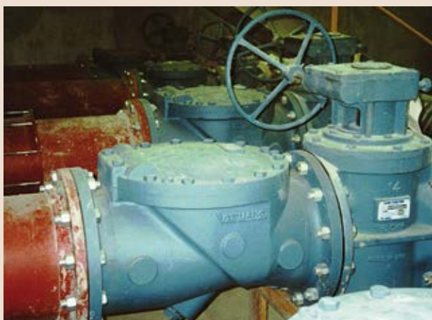
Эксцентриковый конусный кран (справа) и обратный клапан в обвязке канализационного насоса
